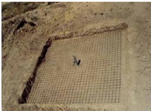
شکل 2- بلوک تیمار بعد از کارگذاری لوله کاتد و شبکه آند
