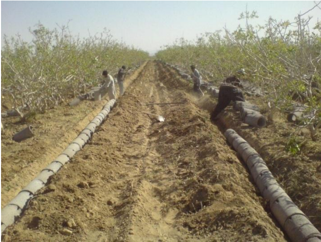
شکل ۱- وضعیت نصب و استقرار لوله‌های زیرسطحی سیمانی در کنار درختان پسته قطعه آزمایشی
