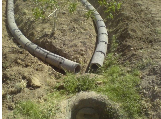
شکل ۱- وضعیت نصب و استقرار لوله‌های زیرسطحی سیمانی در کنار درختان پسته قطعه آزمایشی
